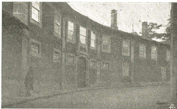
Foi nesta casa, sita na Rua do Campo Alegre, n.º 163, no Porto, que nasceu o grande filantropo Diogo Cassels
